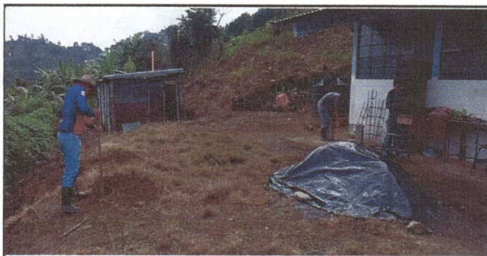
Foto 3: SE OBSERVA LA AMPLIACION DEL CORREDOR, COLOCANDO LA CAMA DE PIEDRA, POSTERIOR A LA FUNDICION Y POR ULTIMO EL SERNILLADO DE LA MISMA
