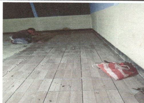
Foto 2: SE OBSERVA EN LA FOTOGRAFIA EL AVANCE DEL MEJORAMIENTO DEL PISO, COLOCANDO PISO AZULEJO EN LAS DOS AULAS.
