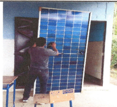
Foto 4: SE INICIA LA COLOCACION DEL CABLEADO ELECTRICO ESPECIALMENTE PARA EL PANEL SOLAR.
