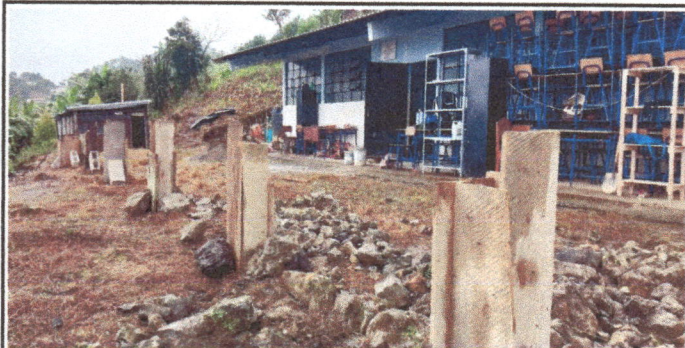
FOTO 1: LA SIGUIENTE FOTOGRAFIA SE OBSERVA EL AVANCE DE LA COLOCACION DE BASE DE CONCRETO QUE SERVIRA PARA LOS PILARES PARA LA COLOCACION DEL ENTECHADO.
